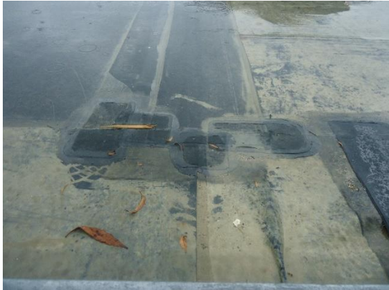
Photo : PAL en juillet 2015 mettant en évidence les trous bouchés, ainsi que les soudures entre l'EPDM insuffisantes laissant l'eau pénétrer sous la couche.
