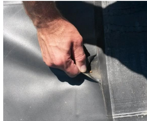
Photo : PAL en juillet 2015 mettant en évidence les trous bouchés, ainsi que les soudures entre l'EPDM insuffisantes laissant l'eau pénétrer sous la couche.
